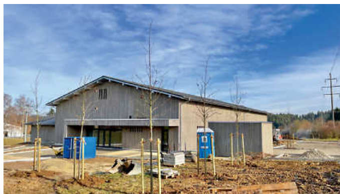
Der Neubau der „Haselbuckhalle“ erinnert an eine moderne Interpretation einer Feldscheune und fügt sich wie selbstverständlich in die Umgebung ein. (Foto: Günter Limberger)
