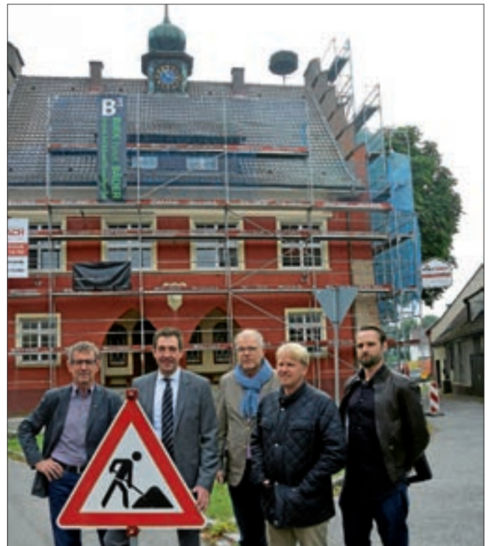
Glückliche Gesichter beim offiziellen Startschuss der Sanierungsarbeiten am ehemaligen Rathaus in Allmendshofen. Von links: Stadtrat Franz Wild, Oberbürgermeister Erik Pauly, Stadtbaumeister Heinz Bunse, Architekt Alexander Schmid und Norman Gartner.
