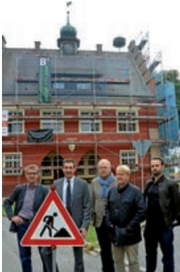
Glückliche Gesichter beim offiziellen Startschuss der Sanierungsarbeiten am ehemaligen Rathaus in Allmendshofen. Von links: Stadtrat Franz Wild, Oberbürgermeister Erik Pauly, Stadtbaumeister Heinz Bunse, Architekt Alexander Schmid und Norman Gartner.
